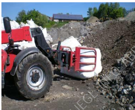
Abb. 8: Häufig nehmen Deponien KMF ausschließlich als Ballen an. Sie werden mit Gleisschotter, gebrochenem Bauschutt oder anderen mineralischen Abfällen überdeckt.
