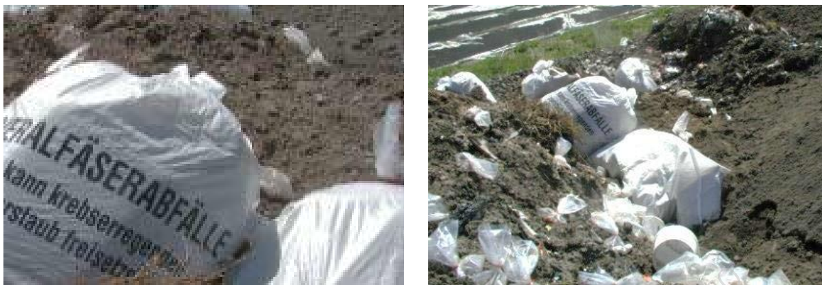
Abb. 7: Auch kleinere Mengen KMF-haltiger Abfälle müssen sofort in reißfeste und staubdichte Bigbags verpackt werden. Anschließend werden die Bigbags auf der Deponie eingebaut und überdeckt.
