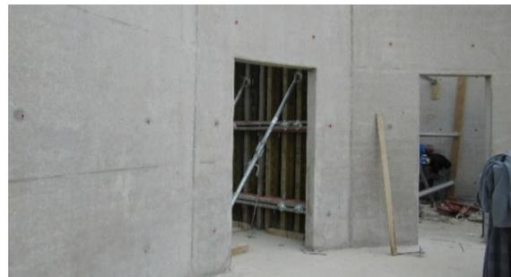
Abb. 24: Sichtbetonteile aus Recycling-Beton [Mettke]
