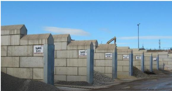
Abb. 10: Blocksteine aus Recycling-Beton für Schüttgutboxen [Mettke]
