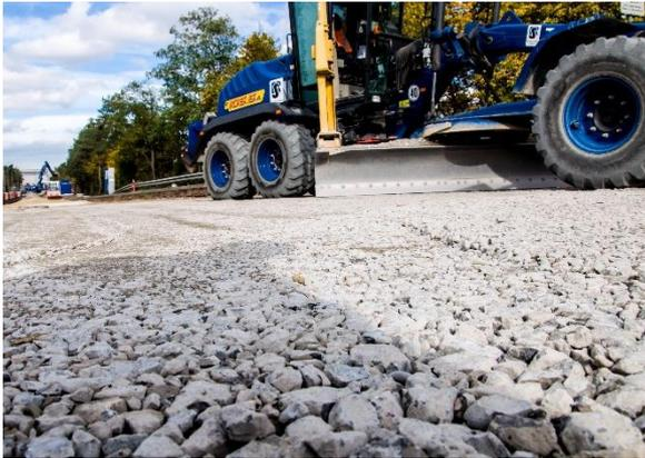
Abb. 9: RC Betongranulat als Frostschutzschicht [SÖR]
