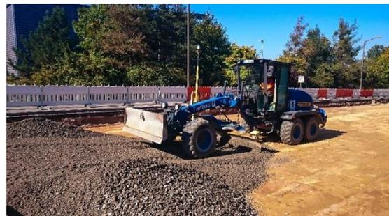
Abb. 20: Einbau Frostschutzschicht [SÖR]
